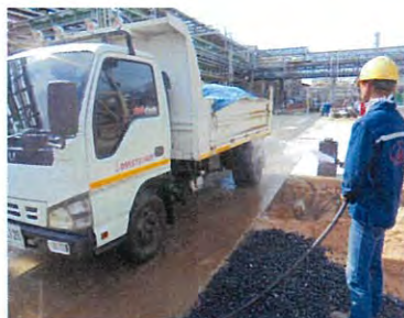
การทำความสะอาดบรรทุกที่ออกจากพื้นที่ก่อสร้าง
