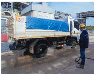
การทำความสะอาดบรรทุกที่ออกจากพื้นที่ก่อสร้าง
